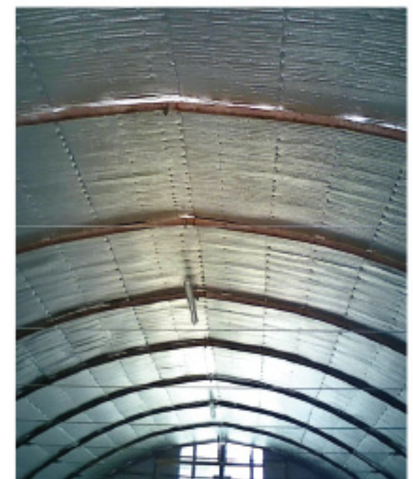
写真7 遮熱シートを設置したD型ハウス
