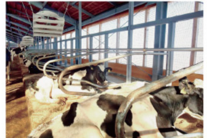
写真6 低い位置に設置された送風機
