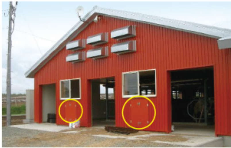
写真3 トンネル換気の入気側 (牛の体に風が当たる位置に設置)
