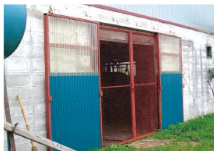
写真2 レールと金属のネットを設置して扉を開放し、開口面積を確保
