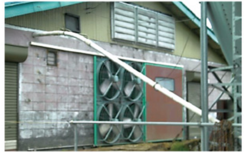
写真4 扉外側に設置したレールに枠を吊り下げ、換気扇を増設
