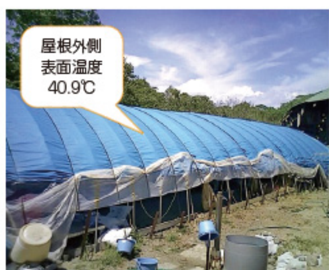
写真3 ブルーシート外側
