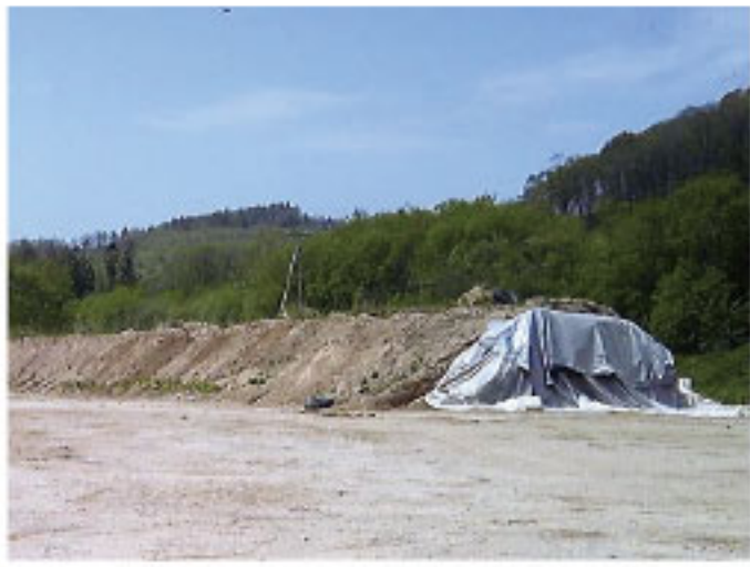
写真3 スタックサイロのシート上に隙間なく載せられた土
